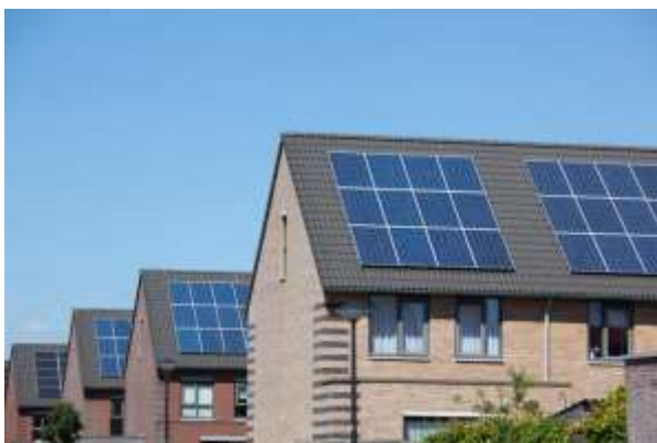
Afbeelding 3.8 Vrije ruimte tussen PV-panelen (Bron: Shutterstock)
