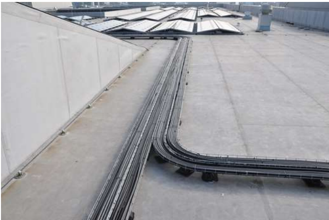
Afbeelding 1.2 Kabeltracé met transportkabels (Bron: TBO GM)
