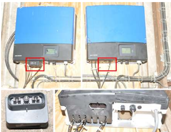
Afbeelding 1.3 Cascade-opstelling van omvormer met DC-plug (Bron: TBO GM)
